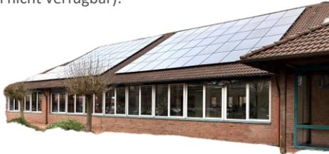
Die „alte“ PV Anlage würde den Wärmebedarf knapp decken, doch die Erzeugung erfolgt hauptsächlich im Sommer, der Wärmebedarf entsteht hauptsächlich im Winter.
