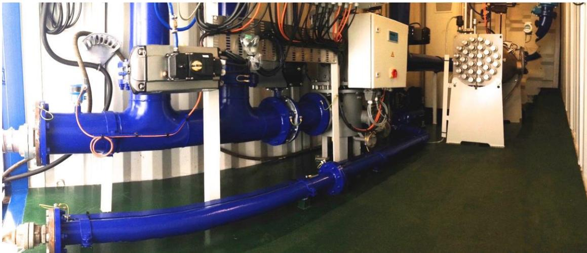
**Abbildung 58: Panorama-Aufnahme der Innenansicht des mobilen Ballastwasser-Prototyps während der Zertifizierungs-Abläufe der Land-based-Tests [22]**
