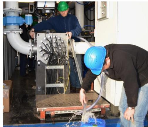
**Abbildung 54: UV-Anlage und Probenahme nach erfolgreicher BW-Reinigung [22]**
